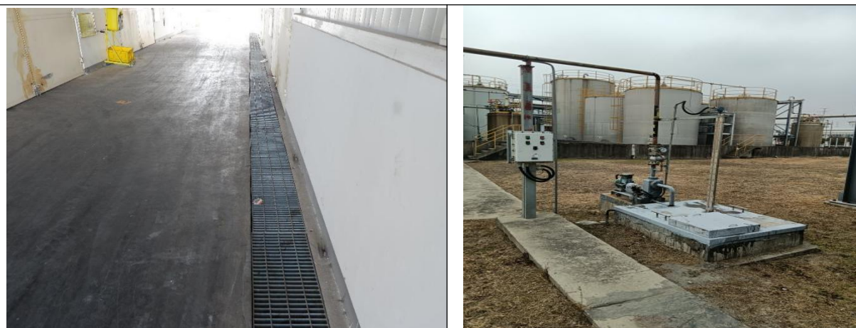
图 6.4.2-6 项目危废仓库收集槽、收集井现状图
